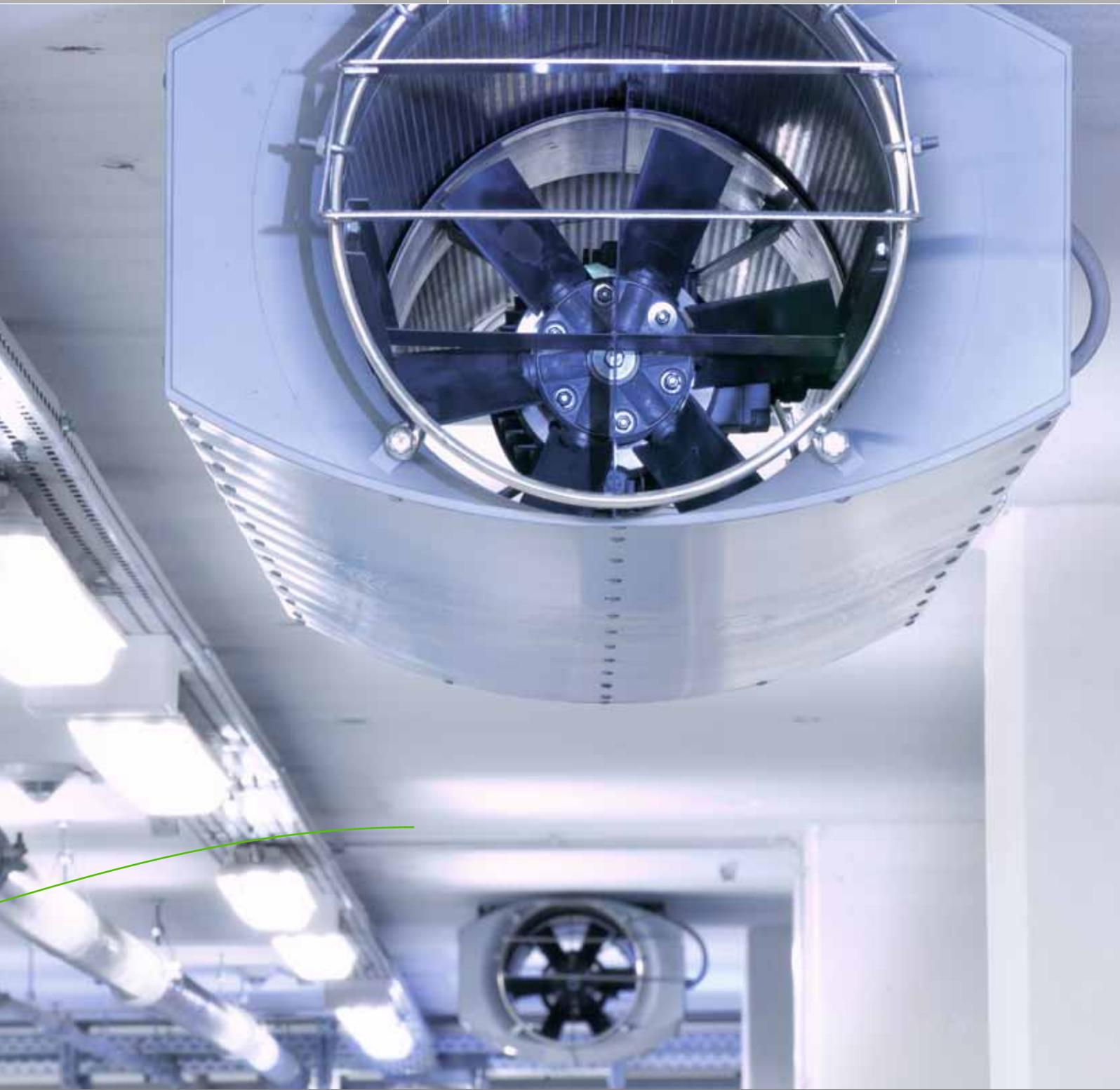
Die Ventilator-Motor-Einheit kann zur Revision aus dem Schalldämmgehäuse ausgezogen werden, was einen wesentlichen Vorteil bei der Wartung bietet.
